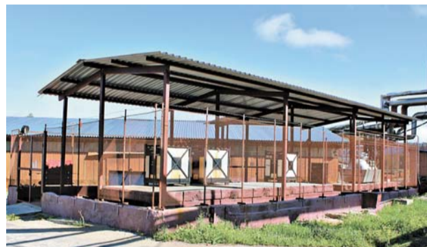
Идет строительство склада кислот цеха № 73.
