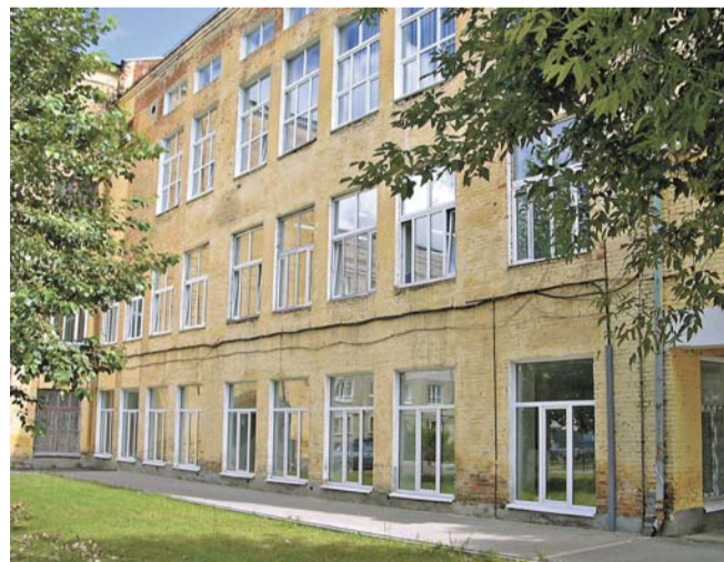
Идет замена оконных блоков в здании ПУ №1.
