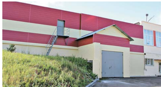
Обновленный фасад корпуса 34 – КИС.
