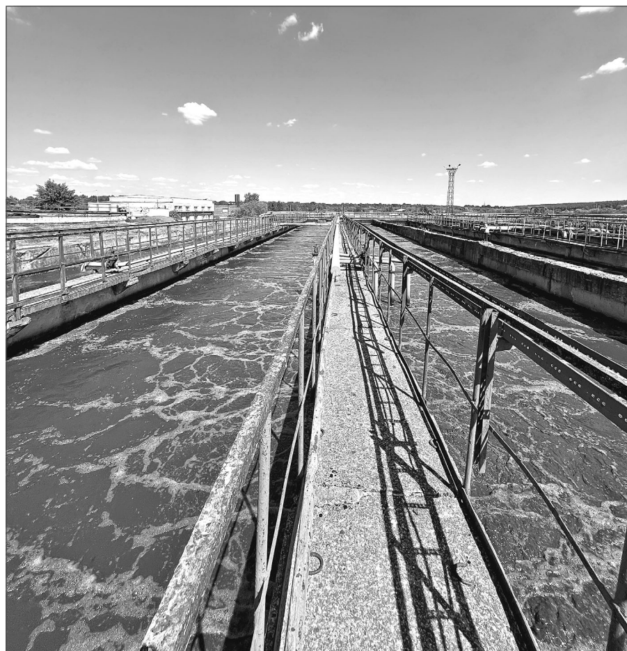
Аэротенк. В зависимости от количества поступающих сточных вод сотрудники очистных могут запустить в работу от 1 до 4-х секций.
