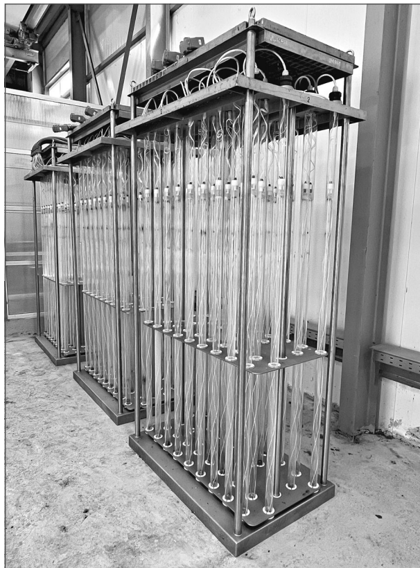
Блок обеззараживания воды.
