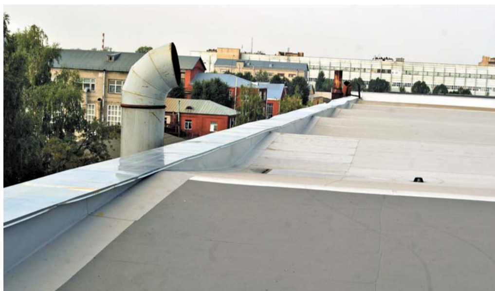
Новая крыша корпуса «З».
