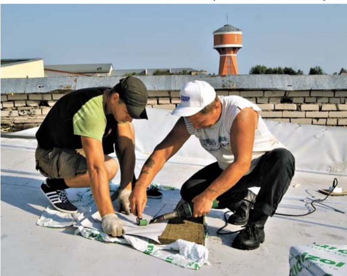
О. Карташов и С. Кузьмин выполняют шов с помощью ручного фена.
