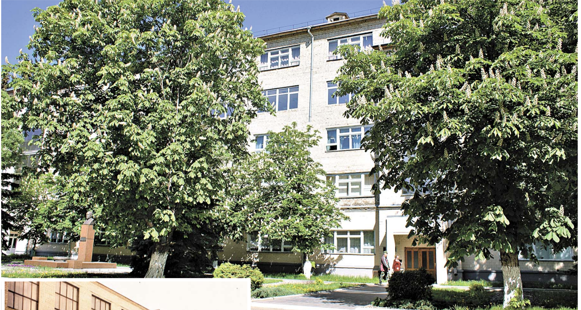
Инженерный корпус. Май 2011г.
