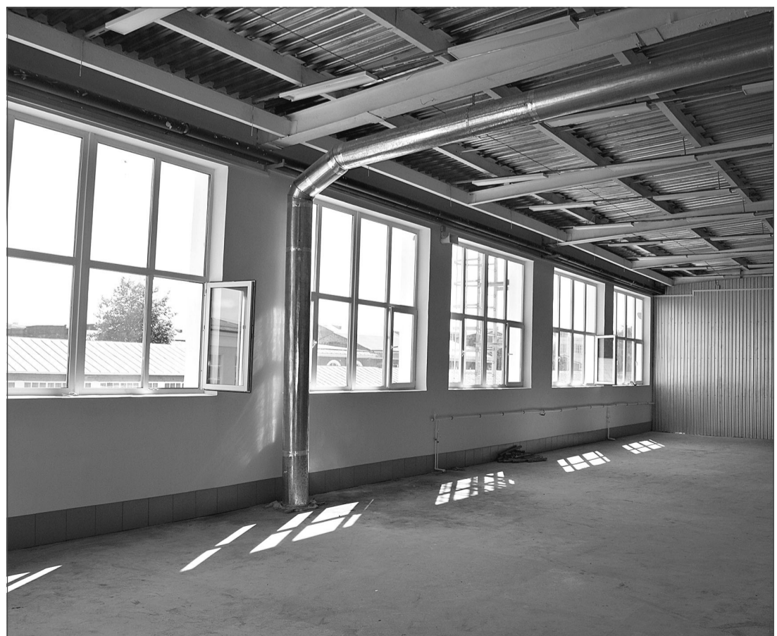
Корпус «Д». Помещение после ремонта.
